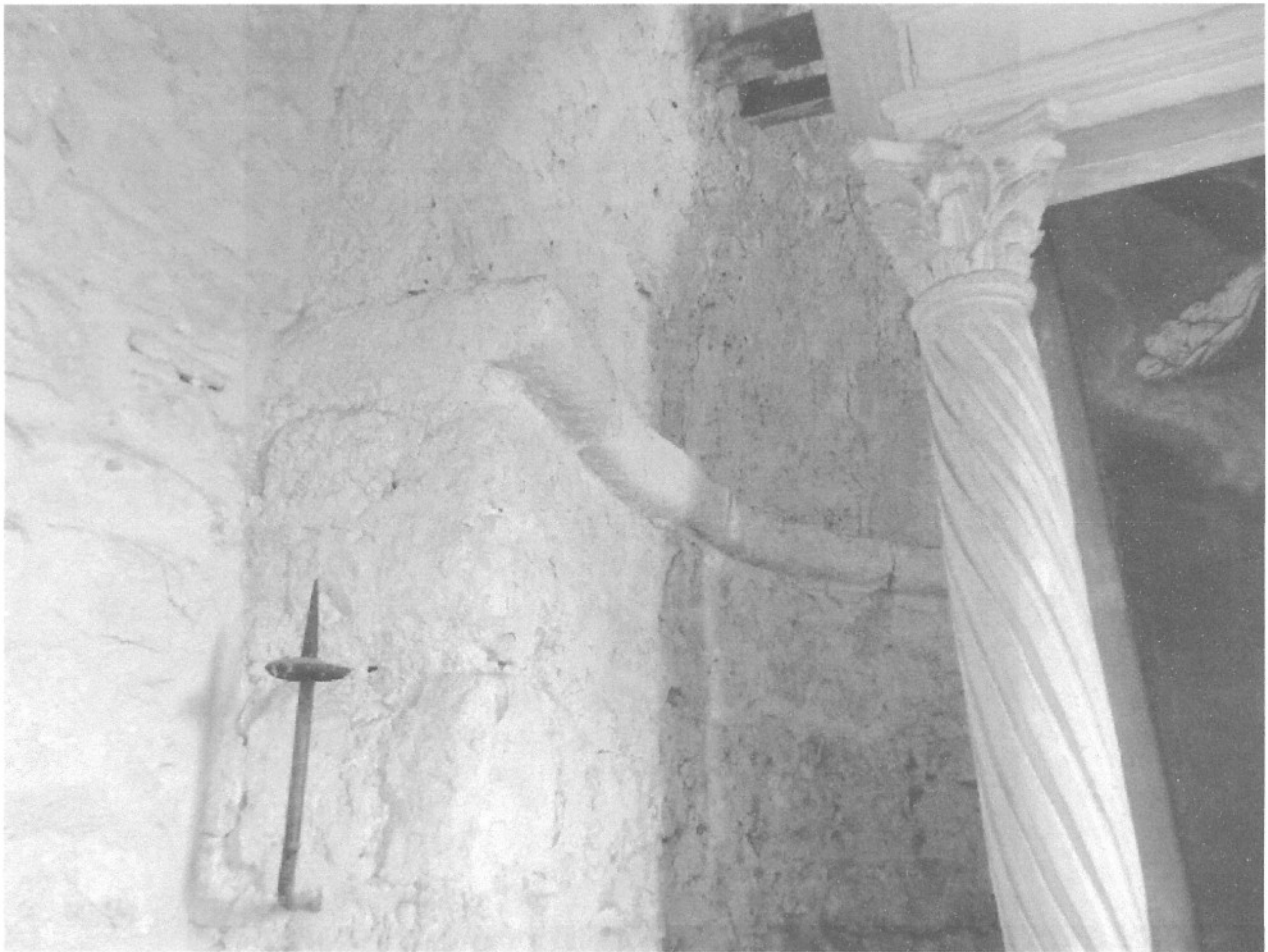
Abside, angle nord-est. Détail de la corniche avec profil rectangulaire.
