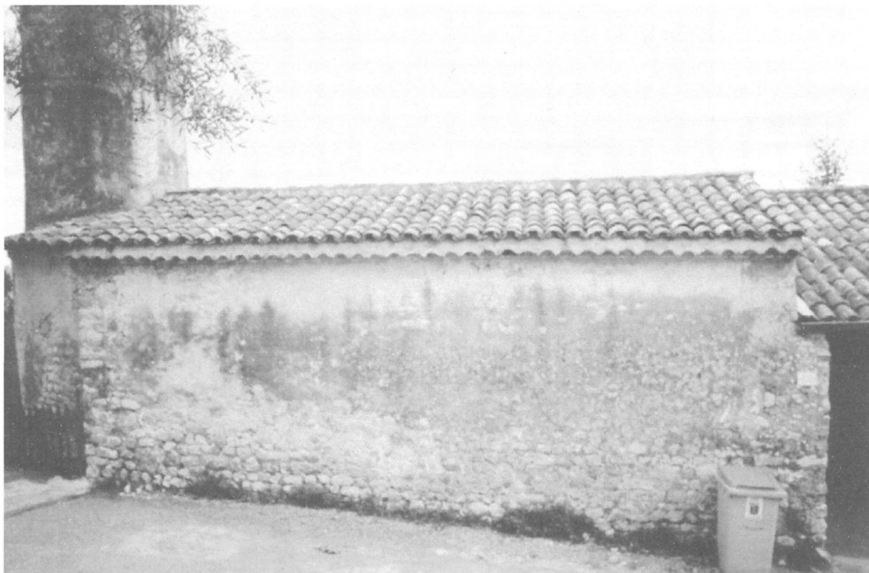
[Vence. Chapelle Sainte-Colombe. Vue de l'élévation nord.]
