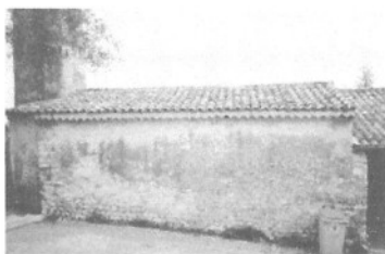
[Vence. Chapelle Sainte-Colombe. Vue de l'élévation nord.]
