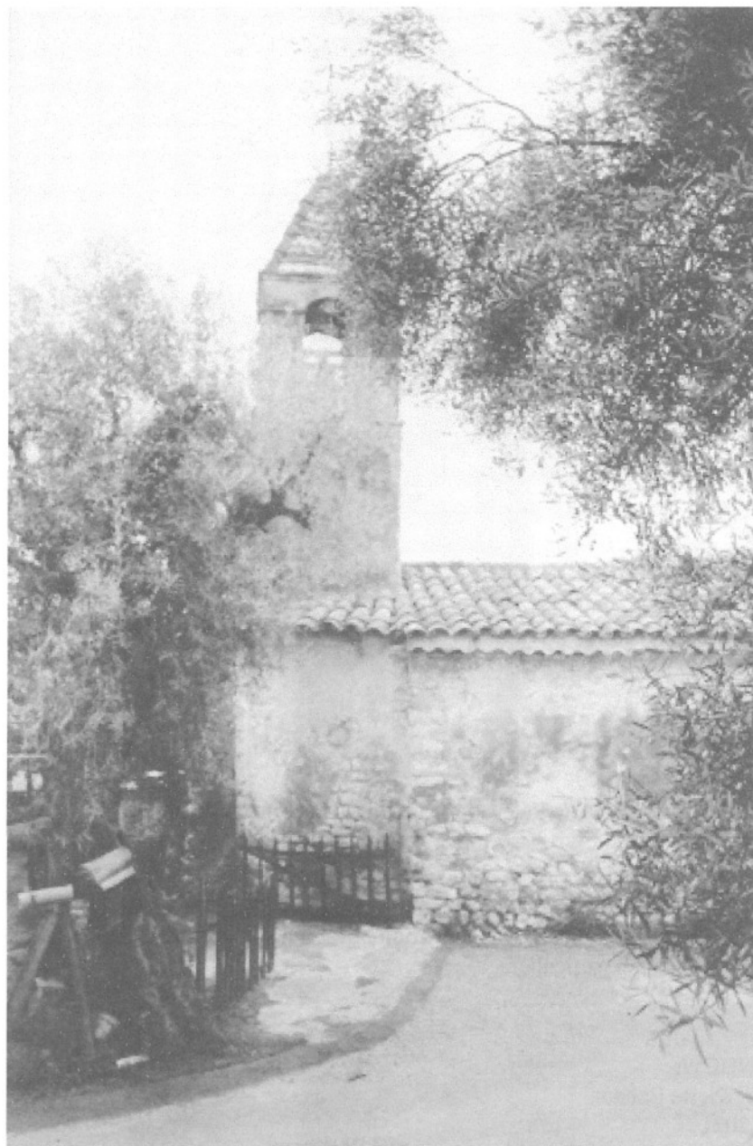
[Vence. Chapelle Sainte-Colombe. Vue de l'élévation nord et du chevet.]
