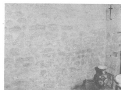
Nef, élévation nord. Détail de la maçonnerie de la phase 1 en partie basse.
