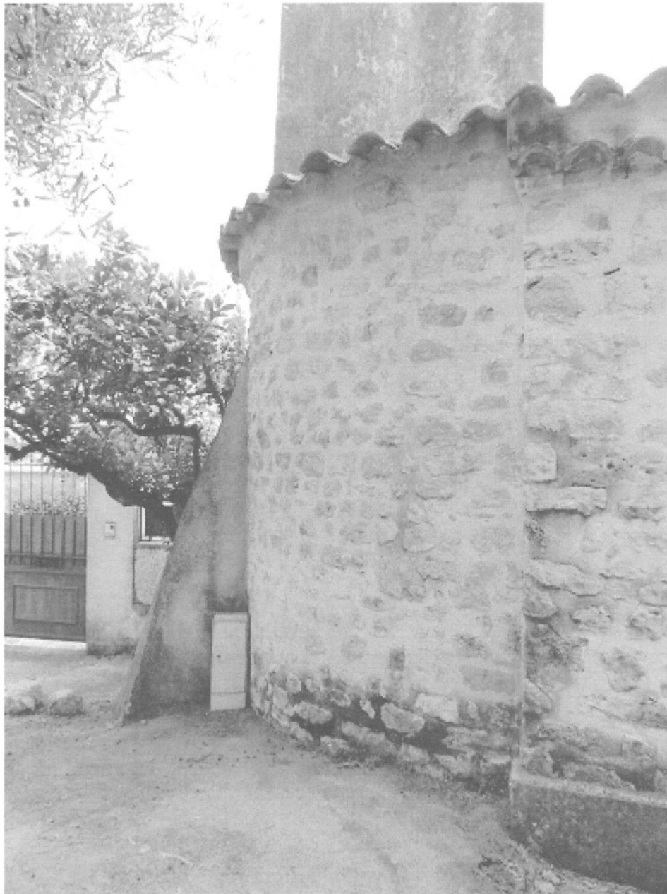
Chevet à l'est, vue d'ensemble prise du nord.
