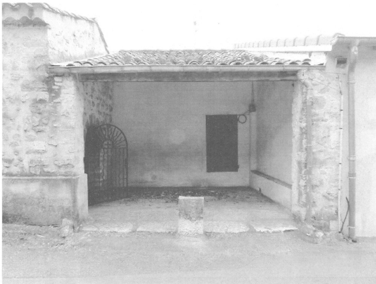
Auvent précédant la chapelle à l'ouest. Vue d'ensemble prise du nord.
