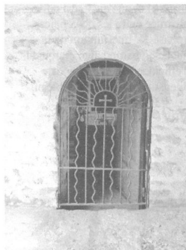
Elévation ouest, porte d'entrée de la chapelle. Phot. Julie Vidal
