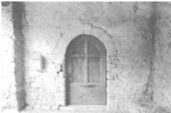
[Vence. Chapelle Sainte-Colombe. Vue de l'élévation ouest avec la porte d'entrée.]
