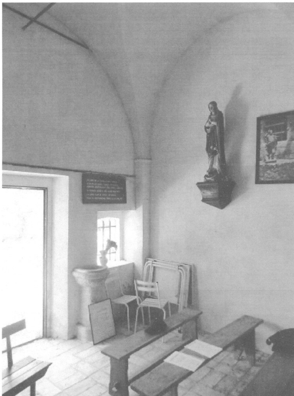
Nef, vue de volume prise du sud-est.
