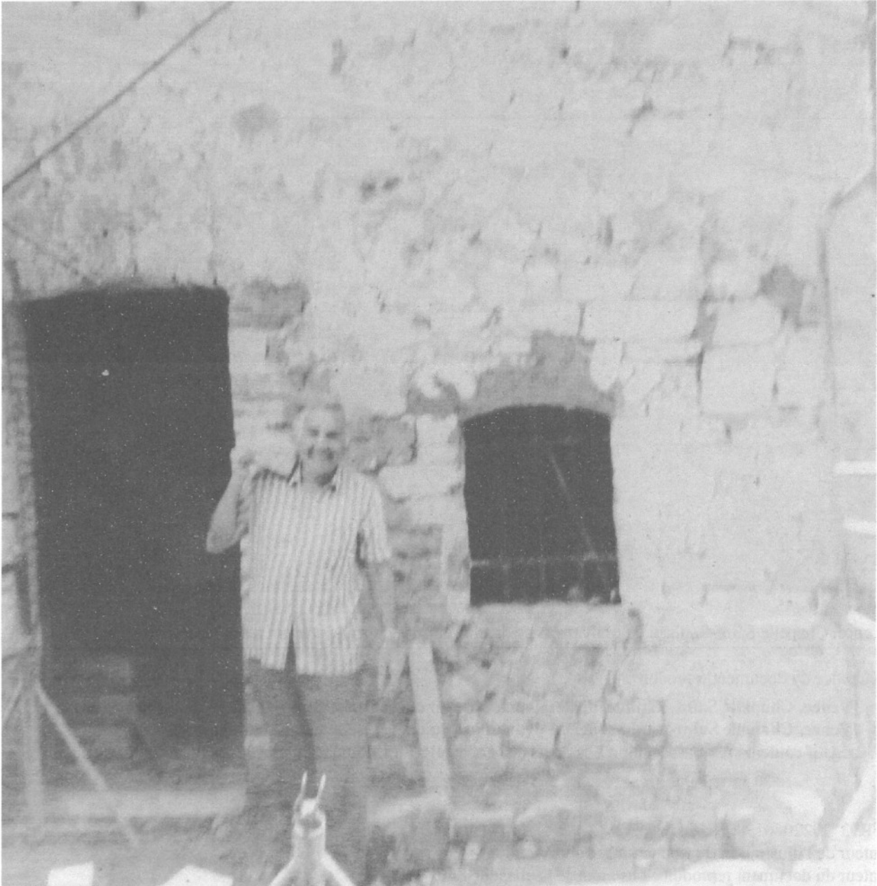
[Vence. Chapelle Saint-Raphael de Malvans. Elévation ouest avant restauration].
