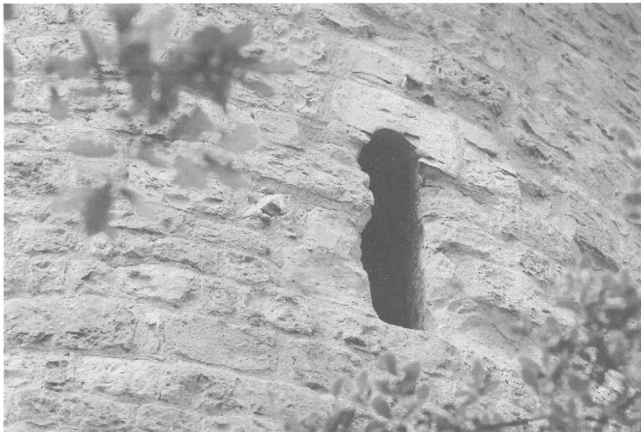
Elévation est, chevet. Baie axiale.
