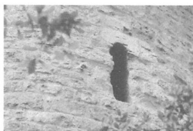
Elévation est, chevet. Baie axiale. Phot. Catherine Poteur IVR93_20220601385NUC1A
