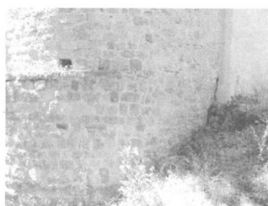
Vue de la partie basse du chevet prise du nord-est. Phot. Julie Vidal IVR93_20220601386NUC1A
